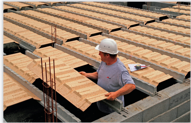
Strop nad przestrzenią wentylowaną. Alternatywne rozwiązanie dla tradycyjnych podłóg na gruncie. Zalety: wentylacja przestrzeni podpodłogowych, eliminacja możliwości popełnienia błędów wykonawczych, zastosowanie zamiast tradycyjnej posadzki na terenach gruntów spoistych to rozwiązanie łatwiejsze w wykonaniu i bardziej ekonomiczne.
